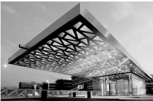
Fassadenbau Beispiel: TRUMPF Empfang
