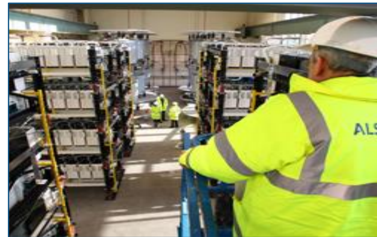
Alstom Grid's MMC结构HVDC 样机
